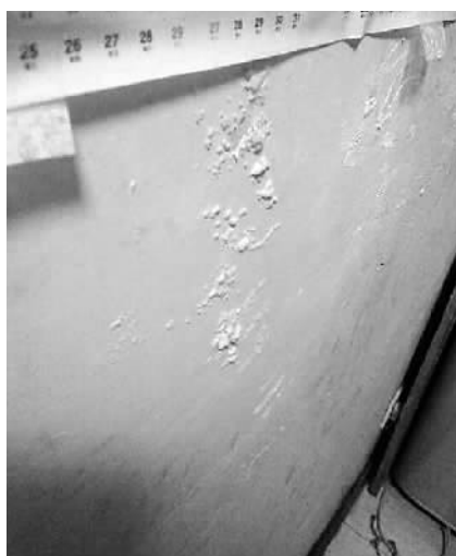
有的居民家墙上长了霉(左),有的渗水严重 本组图片 实习生 汪子晗 摄
